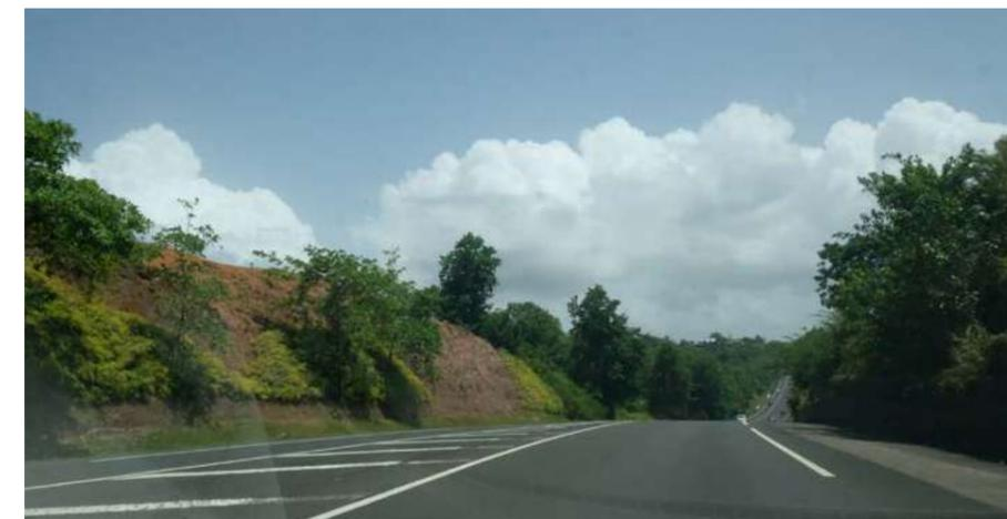
N1 / Goyave : talus routier dénudé soumis à l'érosion superficielle et au glissement de terrain ; pente forte et ligne de pente longue complique l'implantation du couvert végétal
