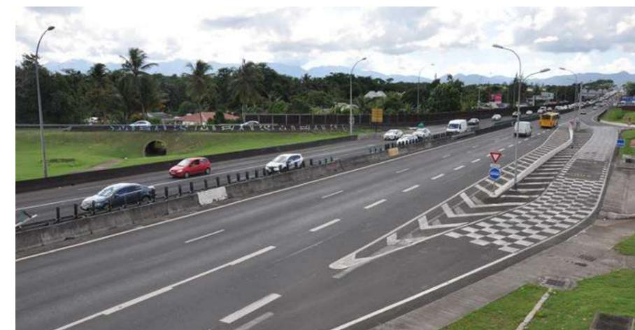
RN1 / échangeur : buse pour passage piéton sous bretelle d'insertion et voie bus avec arrêt de bus
