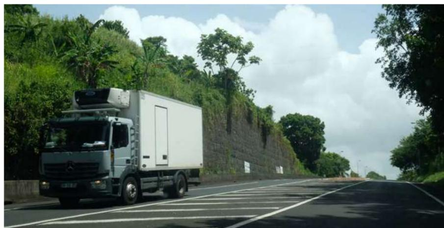
N1 / soutènement en gabions remplis de granulats
