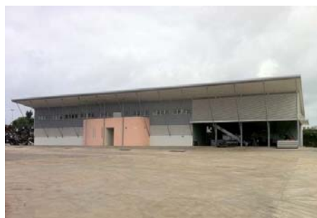
Figure 19 : Photographie illustrant le nouveau bâtiment d'AER (Source : AER)
