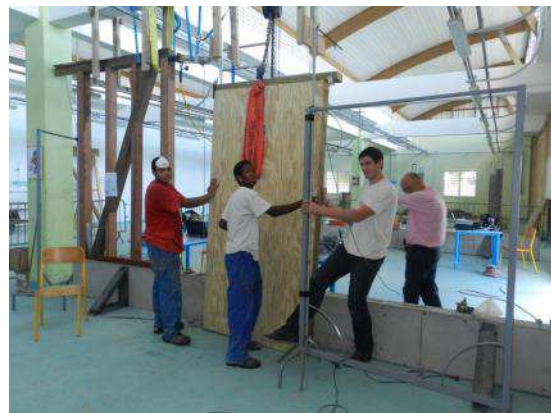
Aide des lycéens à la mise en place d'un panneau Lundi 21 janvier 2013
