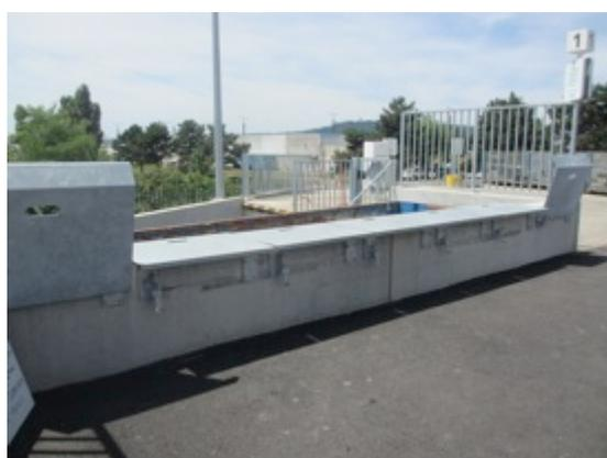
Garde-corps en béton (muret de 0,70 m) + bavettes métalliques basculantes. Coût par quai = 4 000 € HT
