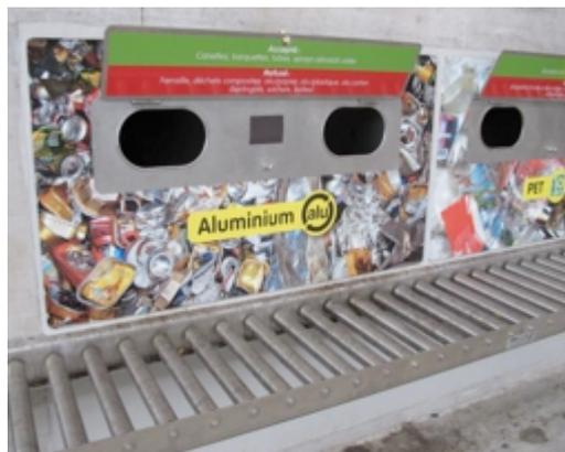
« Le mur du tri » : les usagers déposent leurs petits déchets à travers des trappes dans le mur du bâtiment par type de déchets, réceptionnés dans des bacs à l'intérieur du local de conditionnement.
