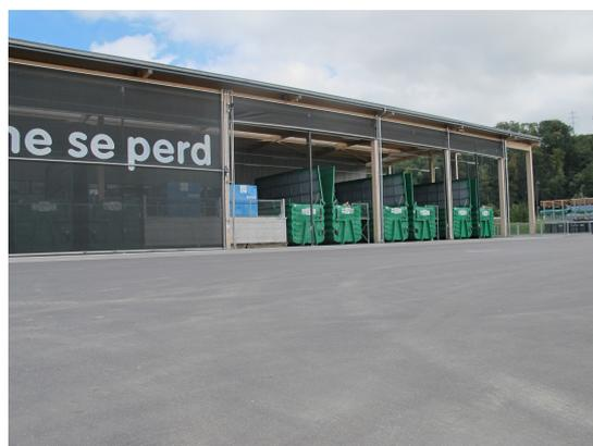
Sécurisation de l'accès aux bennes : les bennes dépassent de 1m10 du quai et des bavettes de protection situées entre la benne et le quai permettent de prévenir des chutes (déchets et usagers).
