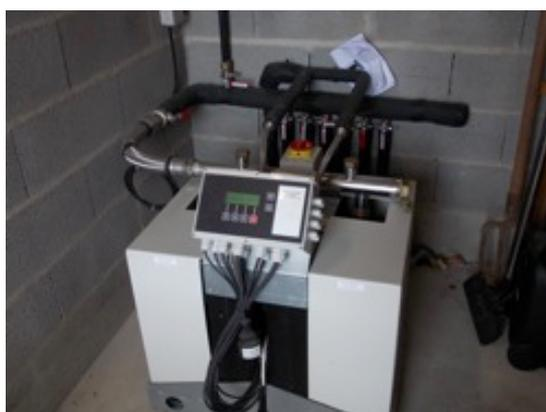
Toiture végétalisée sur le bâtiment central (38 000 € HT) et système de récupération des eaux de pluies (12 000 € HT pour le gestionnaire et la cuve de 10 000 litres). L'eau de pluie récupérée est utilisée pour les sanitaires et le lavage des quais.
