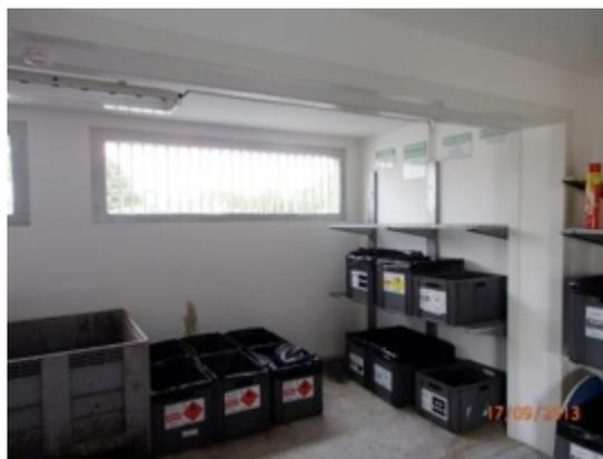
Blocs DEEE et DDS préfabriqués avec rétentions intégrées (1/2 journée pour la mise en place des modules + 2 jours pour les finitions, hors travaux de génie civil avant et après pose des modules).
