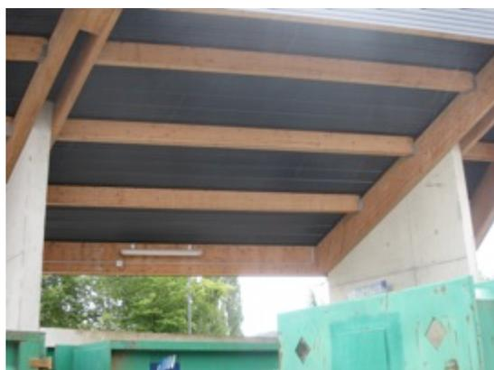
Mise en œuvre de solutions techniques pour la réduction du bruit : écran anti-bruit de 2,2 m en périphérie Est de la déchèterie, couverture avec sous-face acoustique au-dessus des bennes, écrans en béton plein sur la largeur des bennes, garde-corps pleins d'une hauteur de 1 m, optimisation de la position des bennes, adaptation des horaires de passage des camions bennes.
