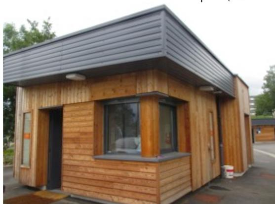
84 m<sup>2</sup> de toitures végétalisées sur les locaux gardien et déchets dangereux (pas d'entretien nécessaire). Construction du local gardien avec des matériaux naturels et isolation renforcée.
