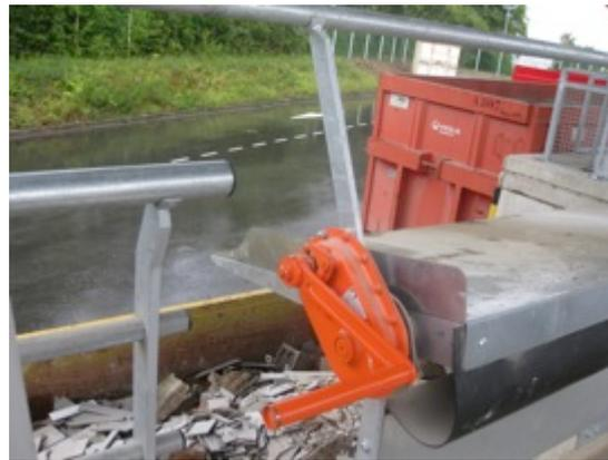
La dépose des gravats est facilitée par la présence d'une bavette métallique pivotante actionnée par une crémaillère (fabriquée par l'Atelier du Fer, entreprise située en Lorraine, coût : 5 865 € HT/quai) : ce système permet de prévenir de la chute de personnes dans les bennes et de faciliter la répartition des déchets suivant l'inclinaison de la bavette.
