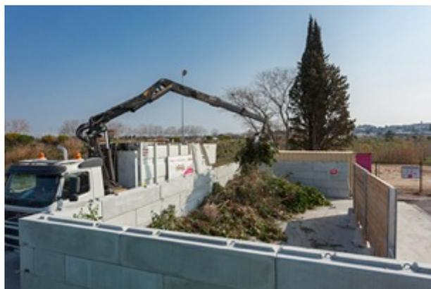
Evacuation des déchets au grappin par dessus les blocs bétons sur voie dédiée.
