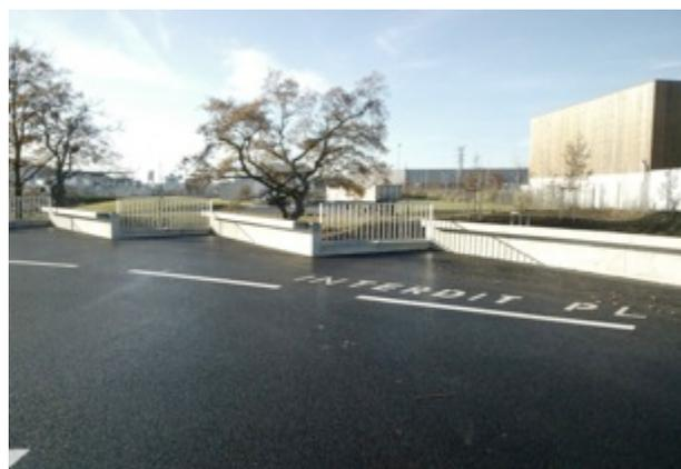
Garde corps maçonné de type muret + débord béton.
